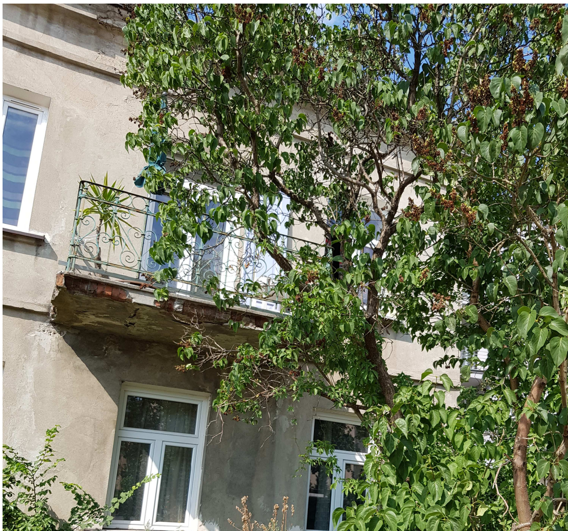
Fot. 2. Widoczne uszkodzenia konstrukcji balkonu – strona południowa
