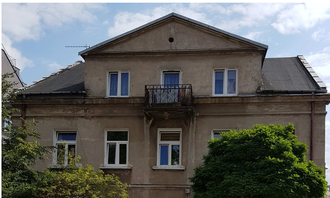
Fot. 3. Widoczne uszkodzenia konstrukcji balkonu oraz liczne zacieki na elewacji – strona północna
