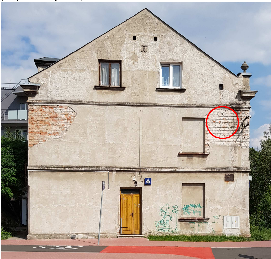
Fot. 1. Widoczne ubytki tynku spękania cegieł
